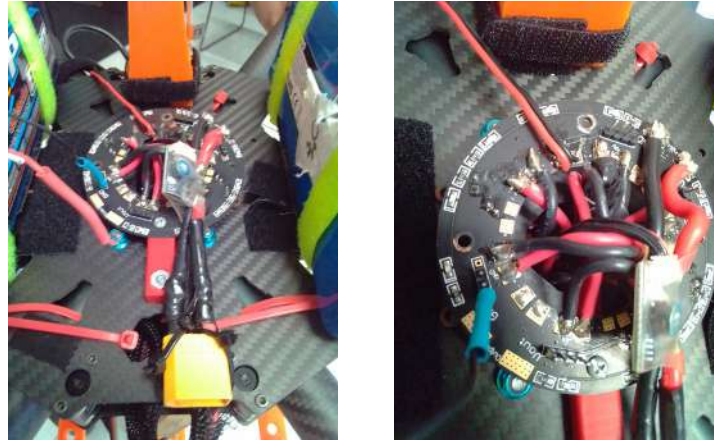
Figura 3.16: Montaje de la PDB en el cubierta.
